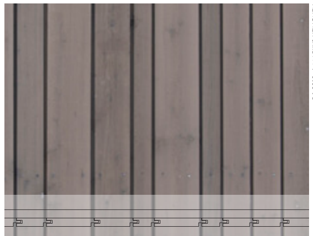
Vaihtelevan levyiset pystyponttilaudat samassa pinnassa. Sakarinmäen koulu, Helsinki.
