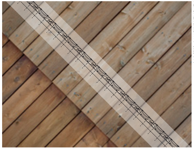
Vinoon asennettu puoliponttilaudoitus. Vuosaaren merimieskeskus, Helsinki.
