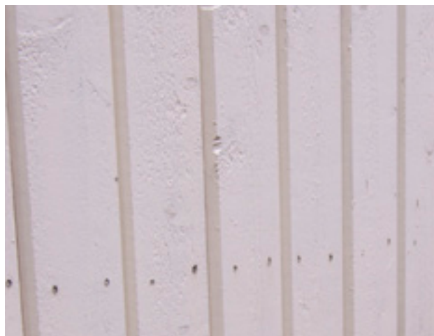
Pontattu pystyлаudoitus. Kiinteistö OY Viikinmansio, Helsinki.
