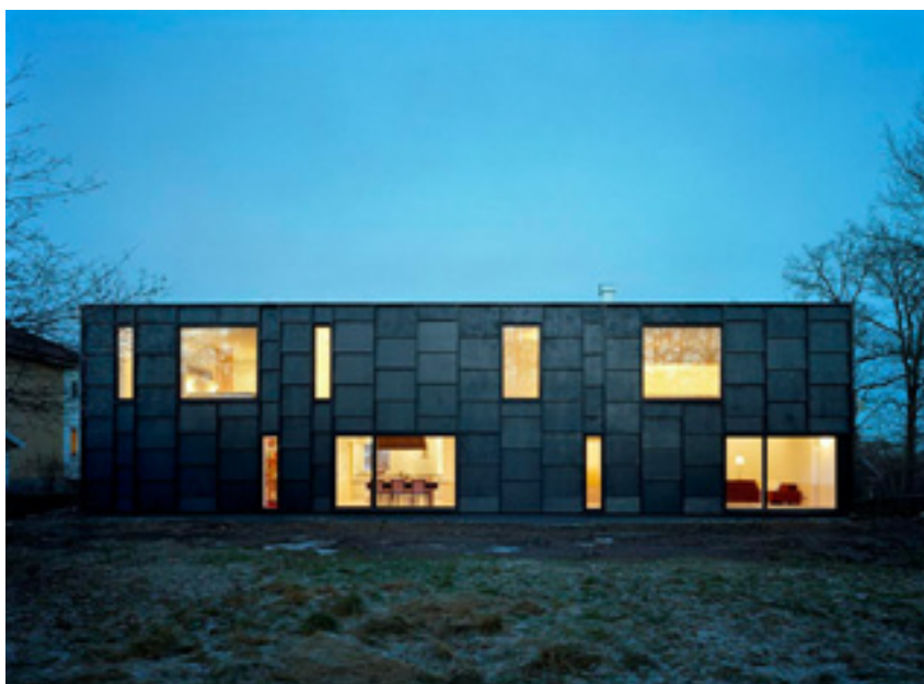
Kuva 1. Tham & Videgård arkkitehtien suunnittelema "K-house"-pientalo Tukholmassa (2004). Julkisivuvanereiden sateelle herkäät vaakasaumat on limitetty paanukaton tapaan.
